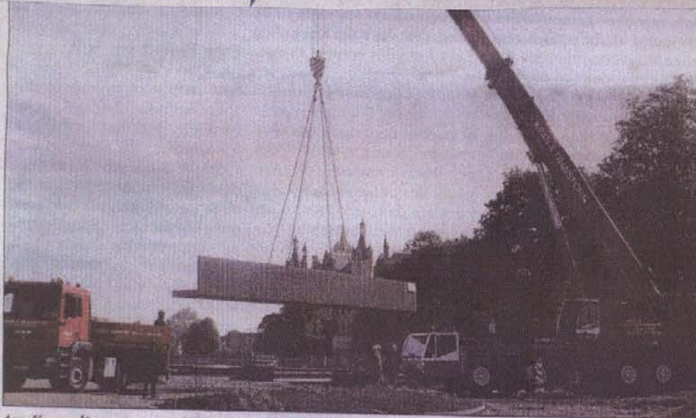
Am Kran die erste von drei Fußgängerbrücken auf dem BUGA-Gelände.
